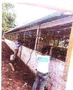
Foto 3: Colocación de balcones para darle seguridad a las ventanas de vidrio.
