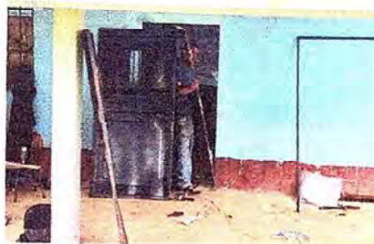
Foto 4: Inicio de la instalación de la puerta de la cocina para darle seguridad a la misma.
