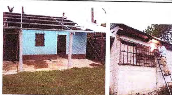
Foto 2: Ejecución del trabajo en el cambio del techo de la cocina y corredor de la misma. Asimismo colocación de balcón en la ventana de la parte de atrás de la cocina de la Escuela Oficial Rural Mixta Chucutá La Unión.
