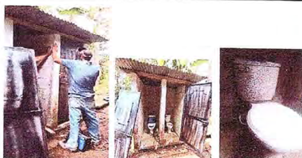
Foto 5: Colocación de 2 puertas de metal a las 2 letrinas lavables de la Escuela Oficial Rural Mixta para brindarles seguridad a los niños y niñas cuando lo utilicen. Así mismo pequeños arreglos en los 2 sanitarios en sus tapaderas y
