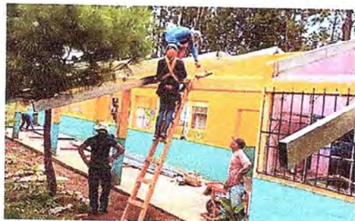
Foto 1: Avance del cambio de techo en las aulas y Dirección de la Escuela Oficial Rural Mixta juntamente con el cambio de las vigas de madera a metal.
